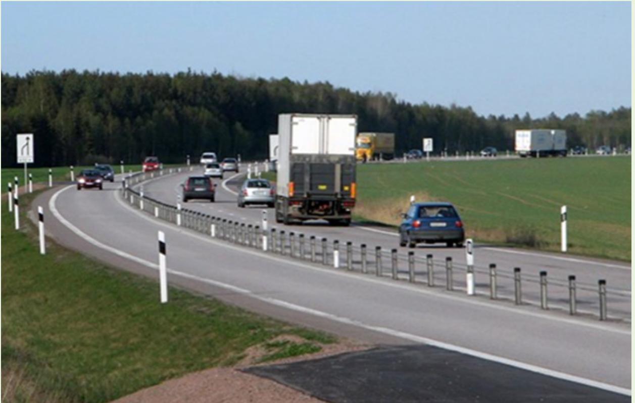
Carretera 2+1 en Suecia con separación de carriles. Fuente: Revista DGT.
